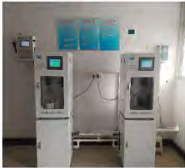
废水在线监控设施
