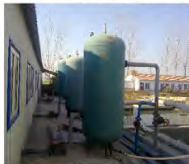
充填站空压机房
