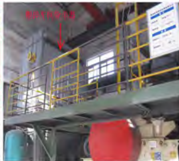
粗碎车间袋式除尘器
