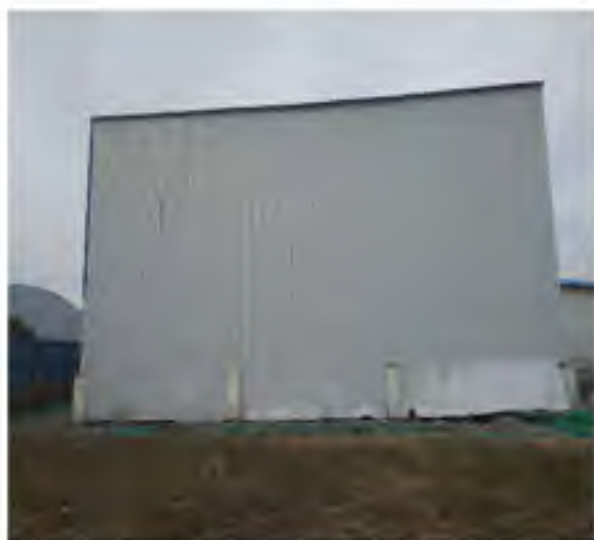
封闭矿石周转场
