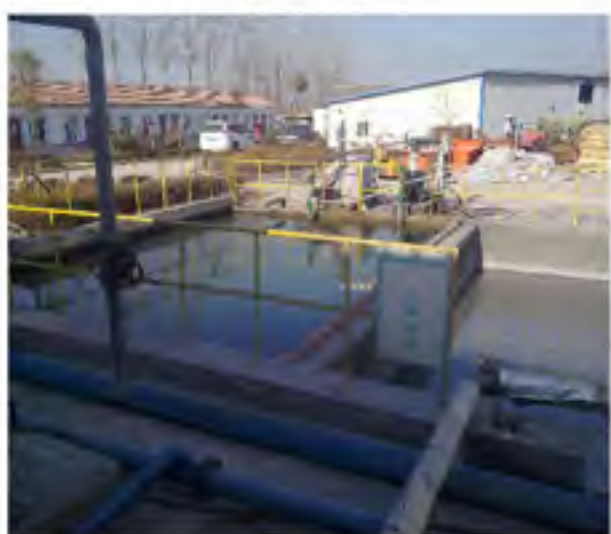
充填站事故池
