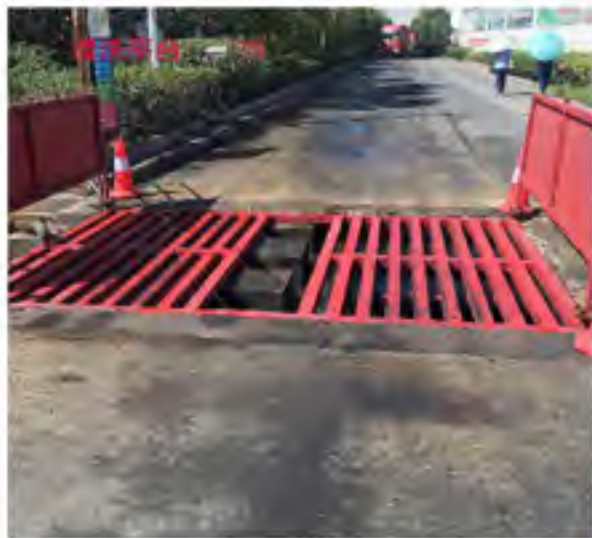
车辆冲洗平台
