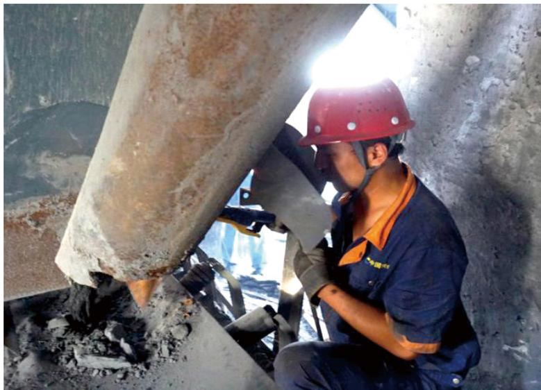
大家便着手对振动筛进行拆卸。振动筛是一个封闭的设备，里面粉尘堆积厚且多，筛网的螺丝一时半会很难找到。大家一边清理粉尘、一边找螺丝、一边拆卸设备。振动筛封闭空间狭小，维修人员进入都要趴下工作，加上天气闷热、粉尘“一触即发”，进去的维修人员脸上、工作服上都被汗水和粉尘包裹着，俨然成了“水泥”人。由于振动筛很多螺丝已被磨损的没了棱角，拆卸十分艰难，大家一起想办法，采用打磨、焊接等各种尝试。拆卸工作就像一件巨大工程一样，每拆下一块筛网甚至每卸下一颗螺丝大家都很兴奋，因为大家离完成任务又迈进了一步。拆卸过程中，大家累了便蜷曲身体稍作休息，稍息片刻便立刻又投入到工作当中去，狭小的空间作业磕磕碰碰在做难免，有的人手上、身上
